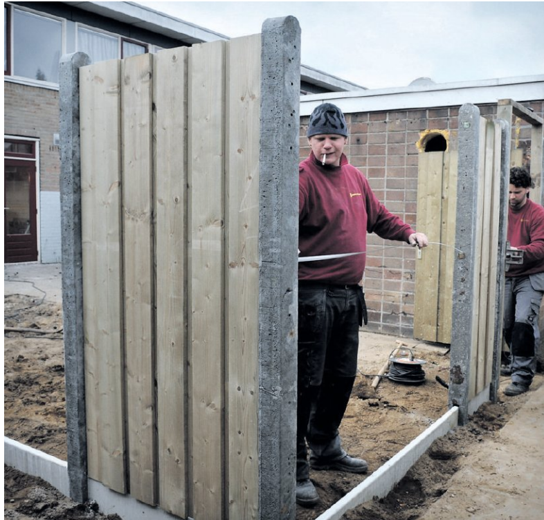
Bouwwerkers plaatsen een schutting. Foto Marcel van den Bergh / de Volkskrant
